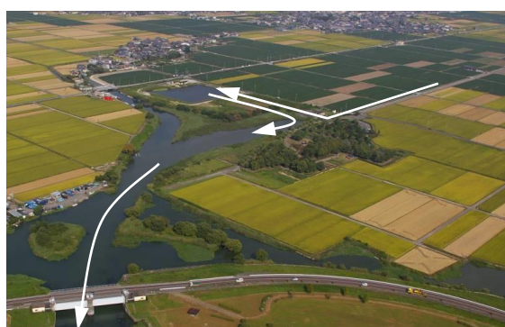
河川直接浄化事業の例(植生浄化)
