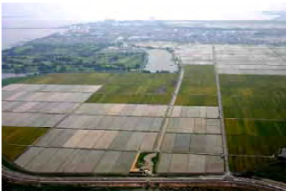
循環かんがい施設の例(木浜地区)
