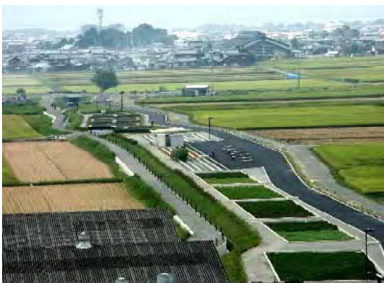
市街地排水浄化施設の例(山寺川)
