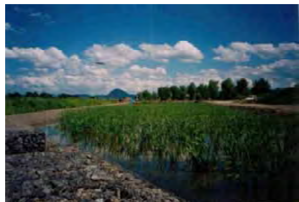
河川直接浄化事業の例(植生浄化)
