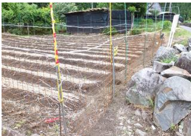
ワイヤーメッシュと通電線を 組み合わせた簡易防護柵
