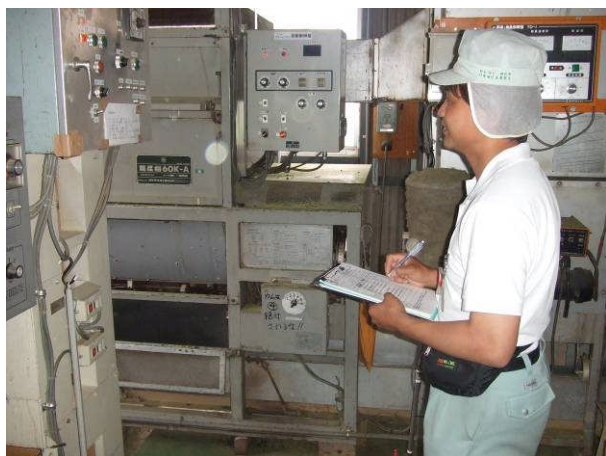
写真1. 茶工場の危険箇所表示状況のチェック
