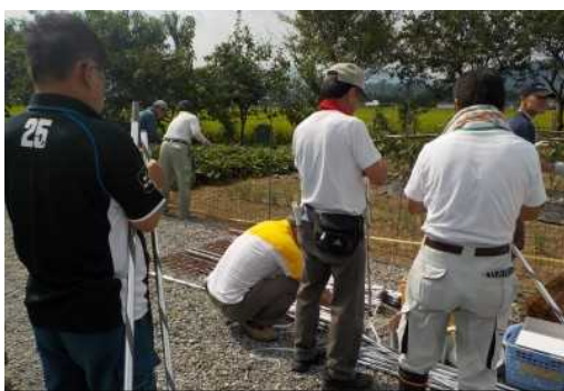
住民の手で設置される防護柵
