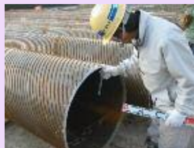
小南高架橋で使った鋼管杭 縞模様の突起があります。
