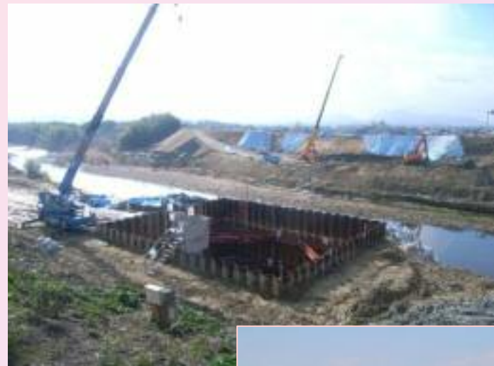
施工中の仁保橋の橋脚 (手前が近江八幡市側) 矢板で締め切った空間の中でコンクリートの柱をつくります。
