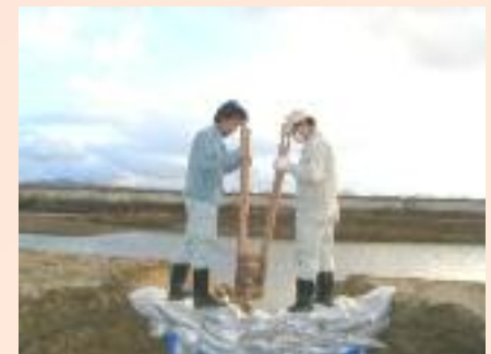
たこづちで土のうを締め固める様子
