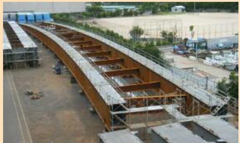
できあがった桁を、いったん工場を組み立てて検査を行います。
