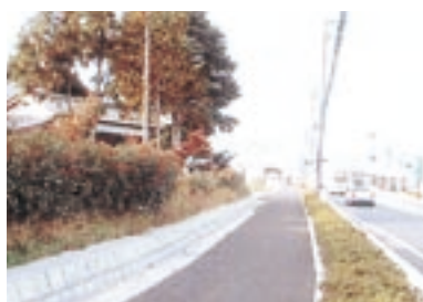
沿道修景整備
