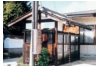
駐輪場（りんりん亭）建設
