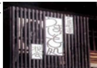
エアコンカバー格子の取付
