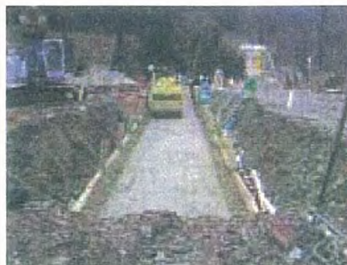
砂防ソイルセメント締固状況
