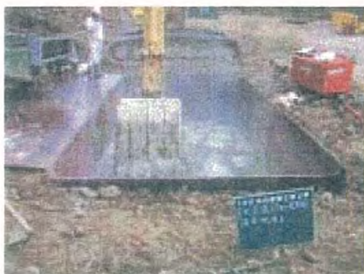
砂防ソイルセメント混合状況
