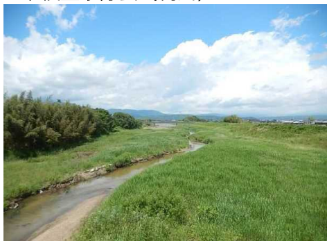
堆積土砂除去（鴨川）
