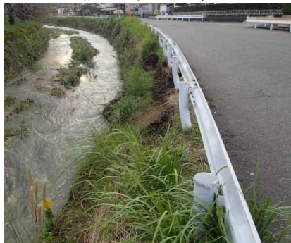
護岸補修等（千丈川）
