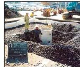
大型浸透ますの施工状況
