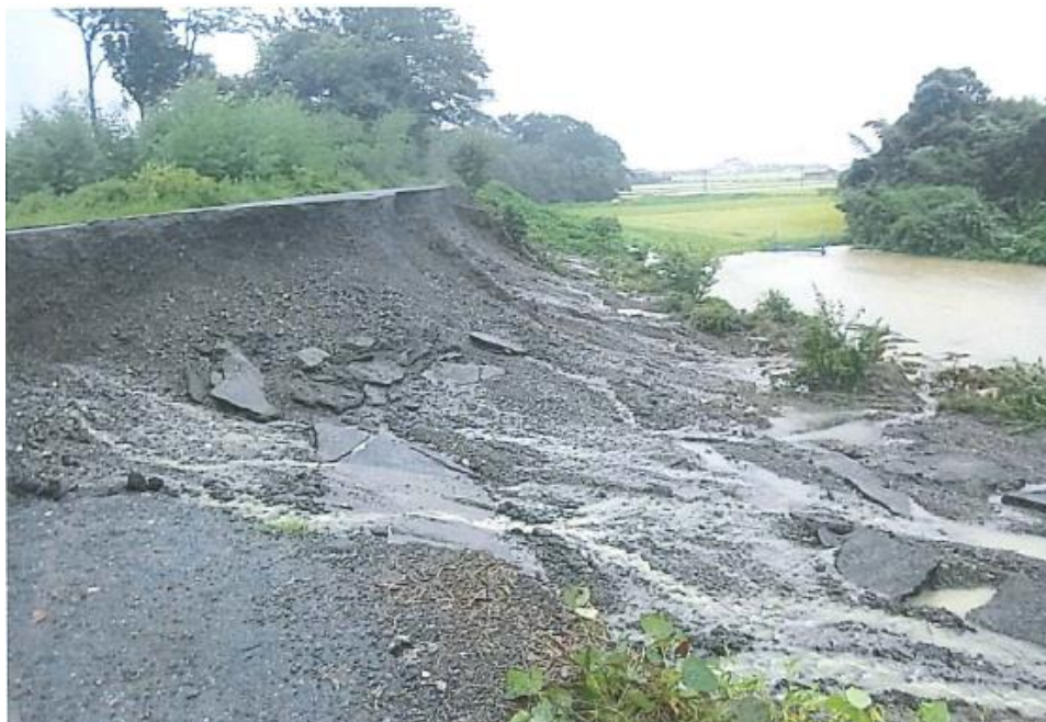
安曇川崩落状況
