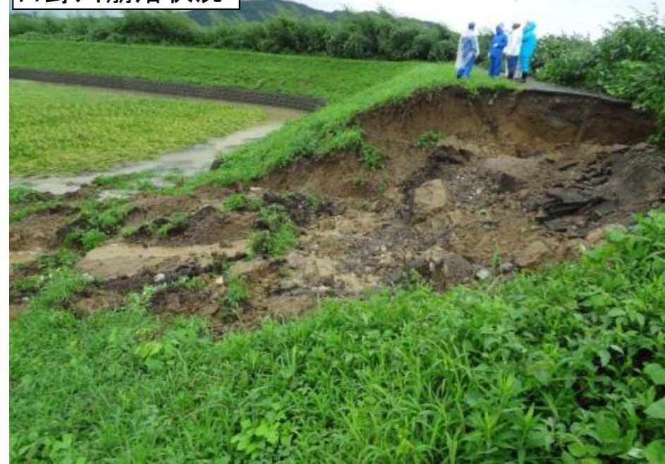
日野川崩落状況
