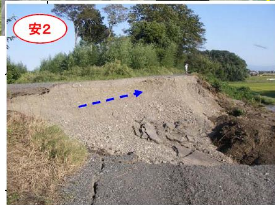
本庄橋上流約1.5km 右岸 堤防法面欠損(堤内) L=58.5m
