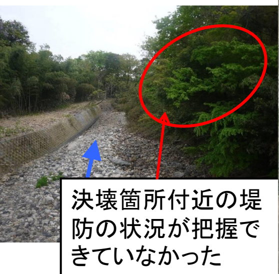
野田橋下流写真(2013/5/10時点)
