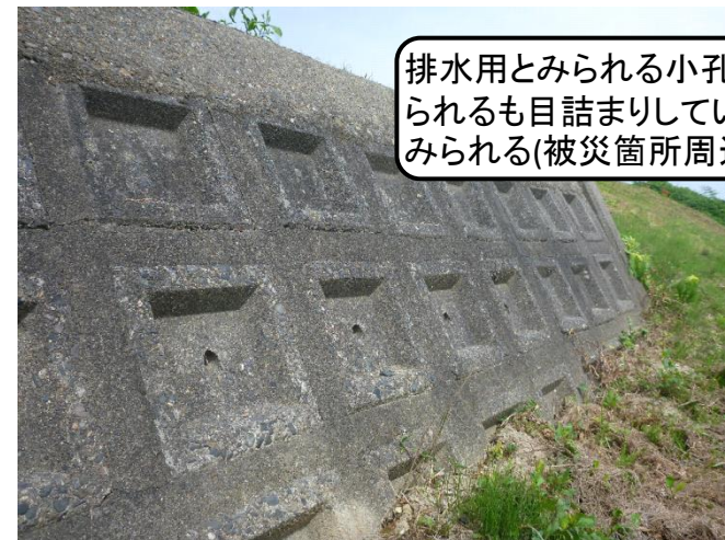
日野川堤体裏法尻に設置された擁壁
