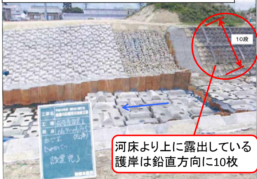
被災前の落差工上流側既設護岸の状況
