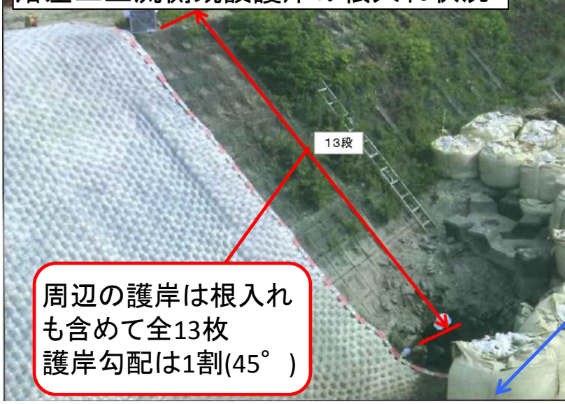
落差工上流側既設護岸の根入れ状況
