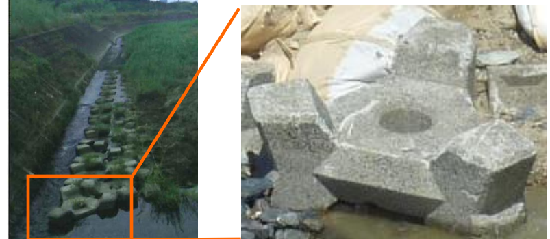
上流湾曲部の護床ブロック
