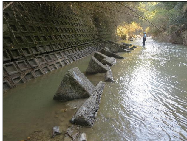
図 ブロックのサイズ・傾きの角度から推定される河床低下量
