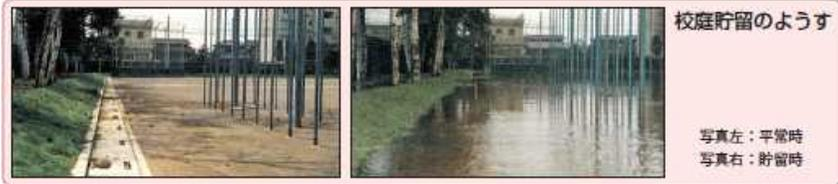
□ グラウンドに周囲堤を設けた窪地貯留と地下貯留槽の併用：富士市立岩松北小学校（静岡県富士市）
