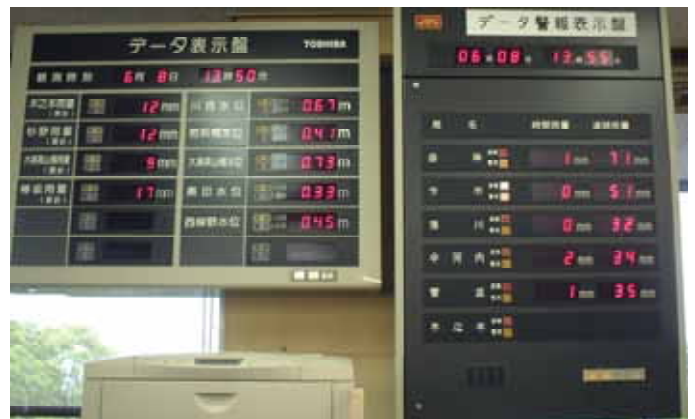
(写真)雨量・河川水位表示盤
