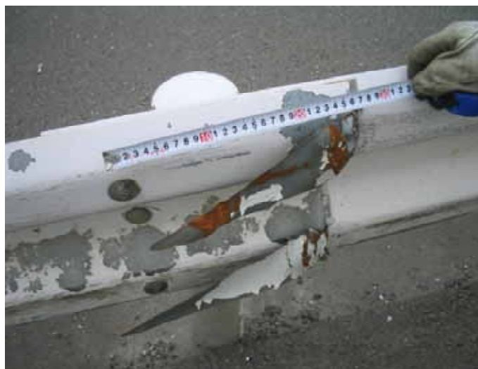
国道365号田部地先にて発見された金属片（写真上）
