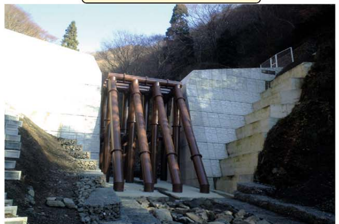
余呉町椿坂地先の下谷川で大きな岩などを止めるために造られたダムです。
