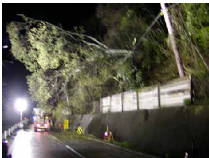
被災状況 (H18.4.20)
