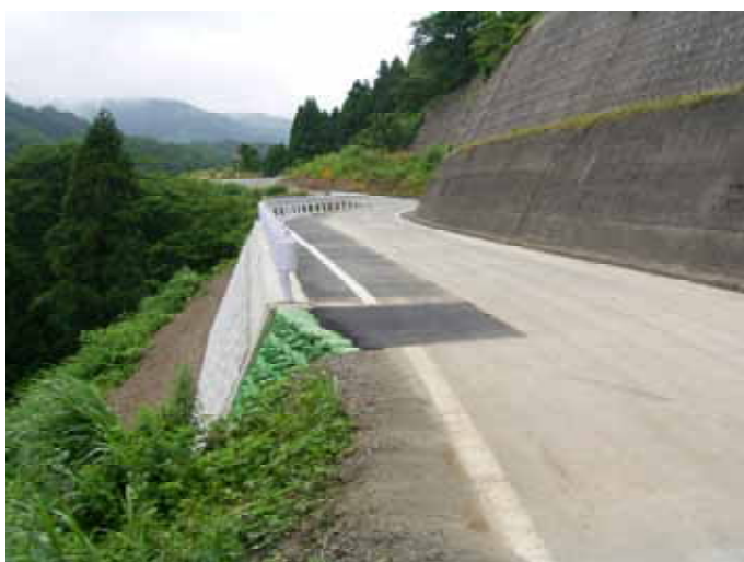
国道365号 復旧状況 (福井県提供)
