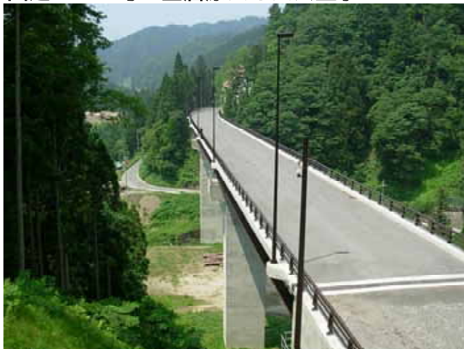
金居原4号橋から金居原地区を望む
