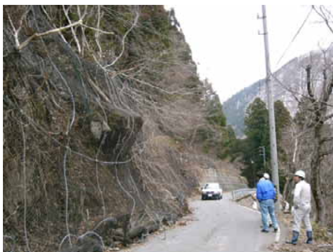
国道303号 被災状況 (岐阜県提供)
