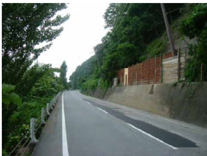
復旧状況 (H18.6月現在)
