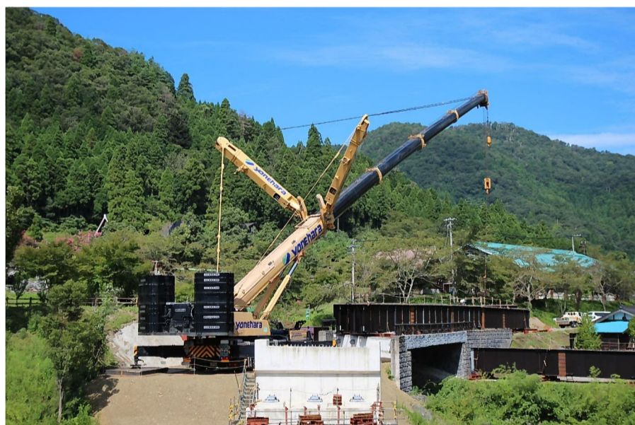
橋桁架設工事の様子 県道中河内木之本線 高時川 H27.8
