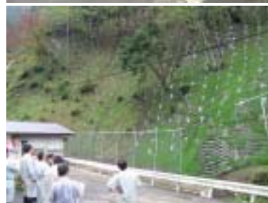
多賀町南後谷地先 急傾斜地崩壊対策事業
