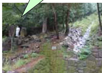
現在の流路工
