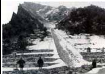
明治の流路工
