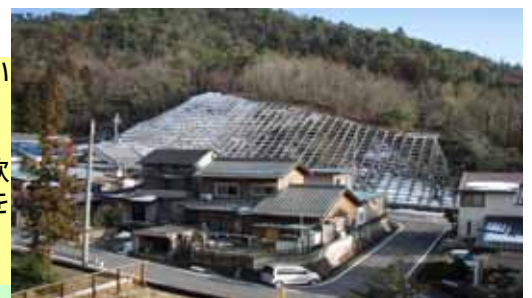
彦根市鳥居本町に完成した急傾斜地崩壊対策施設
