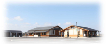
県内 16 番目の「道の駅」せせらぎの里こうら (写真提供: 甲良町)
