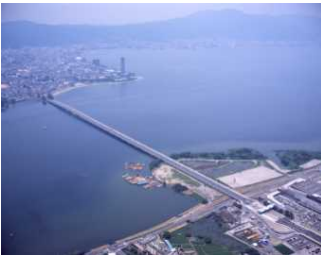
近江大橋 (写真提供: 滋賀県道路公社)
