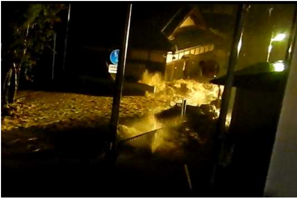
写真-2 「切り通し」からの溢水
