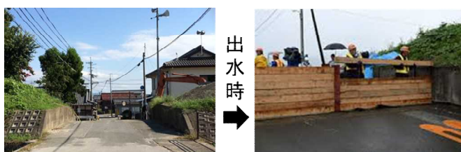
写真-1 「切り通し」の堰き止め作業
