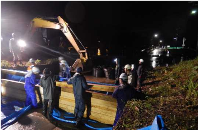
写真-3 災害緊急対応による堰き止め
