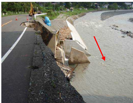
写真-2 平成26年台風第11号による被災状況(下流部)
