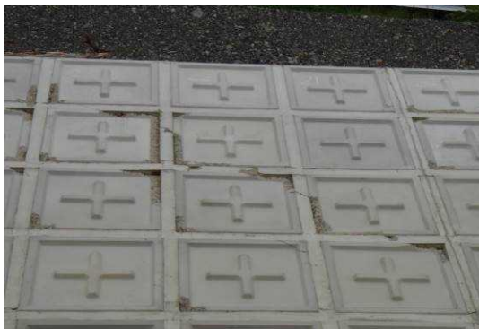
写真-3 平成26年台風第11号による被災状況 上流部ブロックのひびわれ
