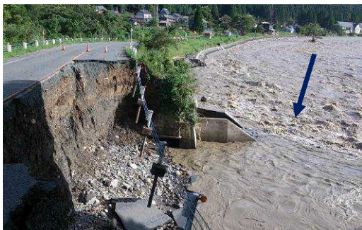
写真-1 平成25年台風第18号による被災状況
