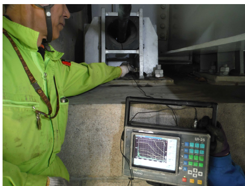
写真-3 瀬田唐橋 (小橋) A1調査状況
