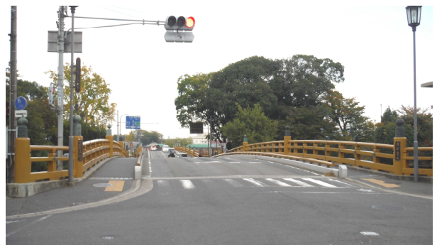
写真-1 瀬田川右岸から瀬田唐橋（小橋・大橋）を望む
