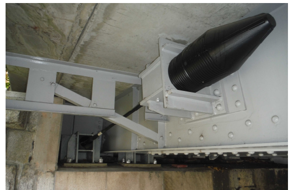
写真-2 瀬田唐橋（大橋）A3橋台部落橋防止装置
