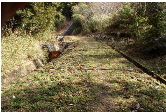
図 4-5 地元で除草等管理されている管理用通路
