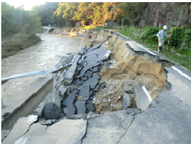
図-5 大津信楽線 道路損壊 大津市上田上牧地先
