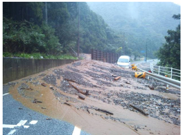
図-2 2012年9月土石流発生状況
