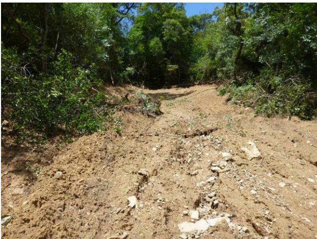
図-7 崩壊地源頭部（専門家撮影 1) ）
