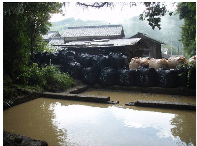
図-13 応急対策工事（瀬田川支流①）
