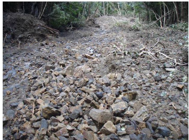
図-11 崩壊土砂堆積状況（瀬田川支流①）
