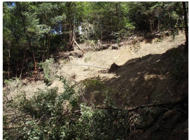
図-12 斜面崩壊状況（瀬田川支流①）
