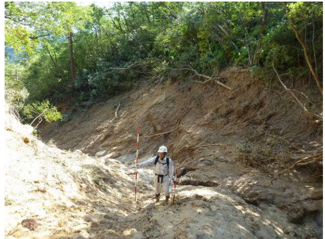
図-8 溪岸侵食状況（専門家撮影 1) ）
