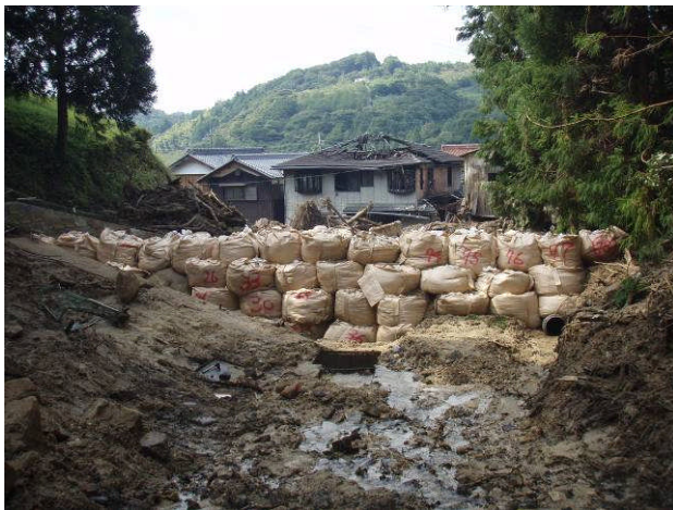
図-10 応急対策工事（瀬田川支流②）
