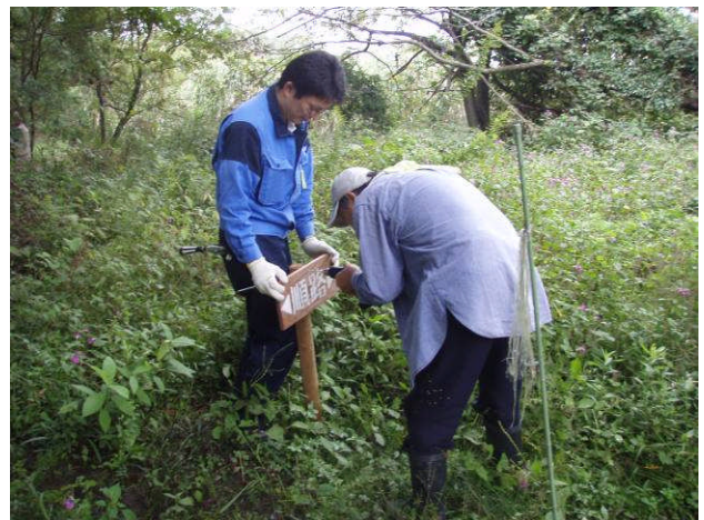
図-6 散策路の整備(順路表示板の設置)
