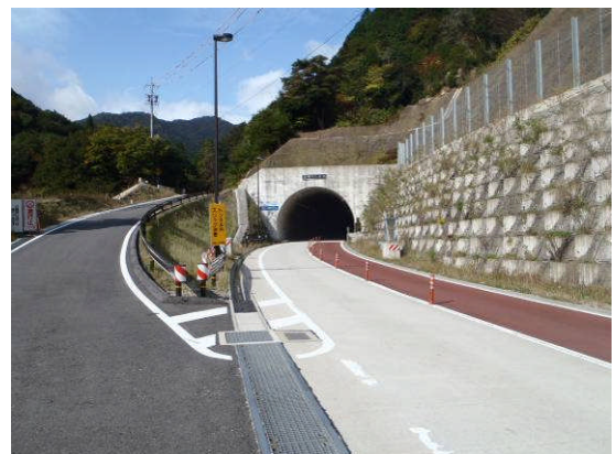
写真-11 石樽トンネル（三重県側坑口）
