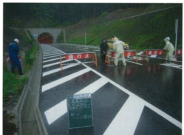
写真-6 トンネル封鎖状況 (単価契約業者との共働作業)
