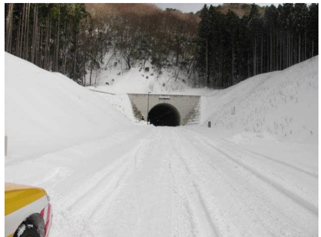
写真-2 積雪時の滋賀県側坑口(H23.12.26)
