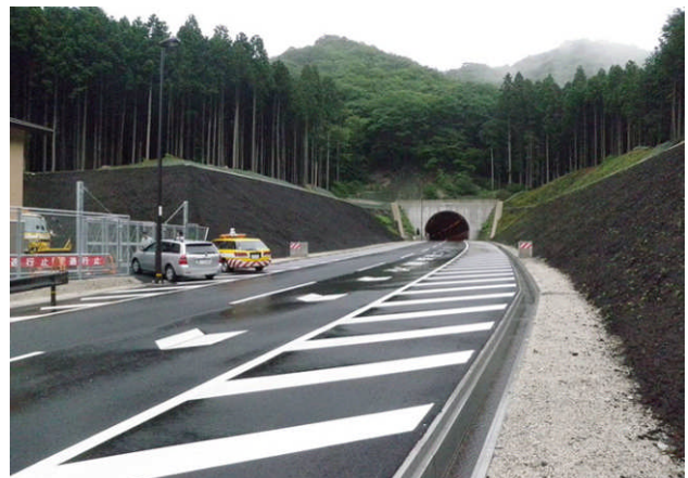
写真-1 石樽トンネル(滋賀県側坑口)
