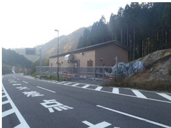
写真-8 石樽トンネル電気室（滋賀県側）
