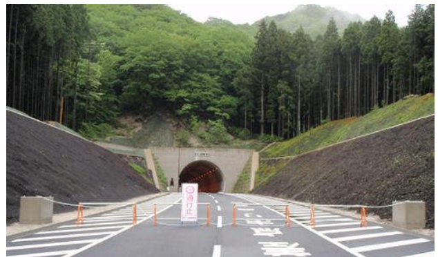
写真-5 石榑トンネル封鎖
