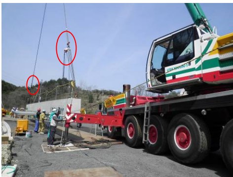
図4-2 合成勾配の調整状況（赤枠：チェインブロック）
