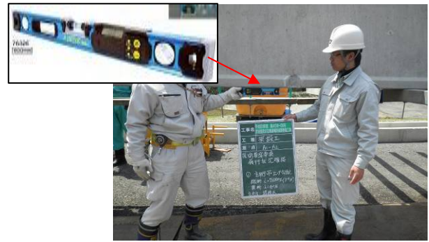
図4-3 縦断勾配の確認状況（電子水平器[左上]を使用）
