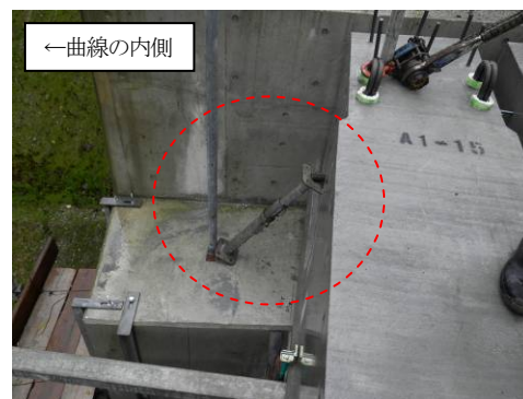
図4-4 転倒防止サポートのG15桁への設置状況
