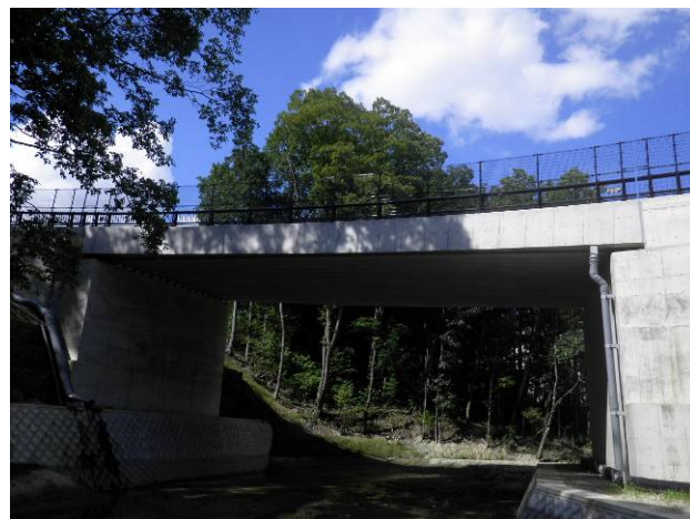
図6-1 完成した小田原橋
