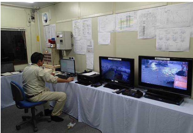
写真-1 中央監視室の状況
