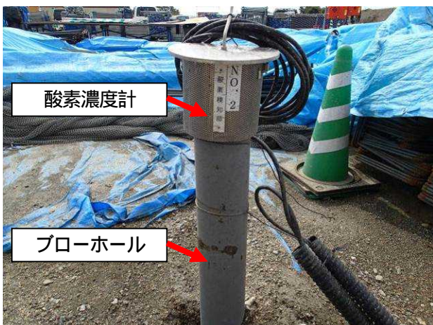
写真-4 ブローホールの設置状況
