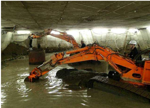
写真-2 作業室内水張り掘削の状況
