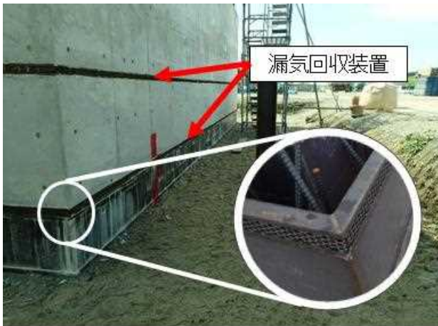
写真-3 漏気回収装置の設置状況
