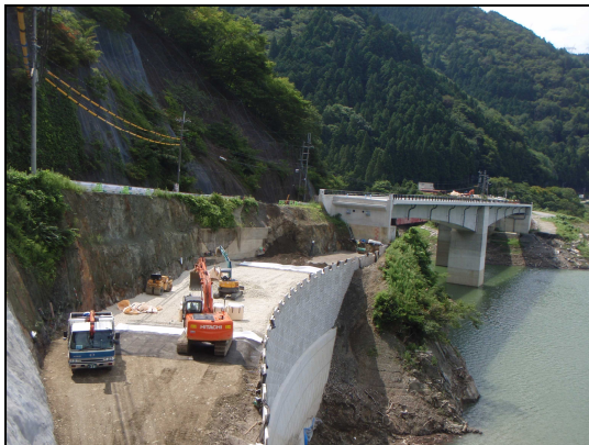
図-6 軽量材施工状況
