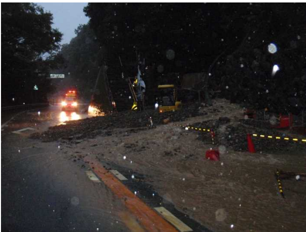
写真-1 現道の土砂流出状況 (H25.9)
