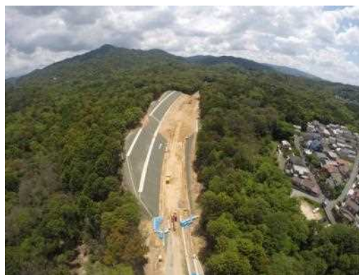
写真-6 関津トンネル坑口付近の整備状況(H26.7)
