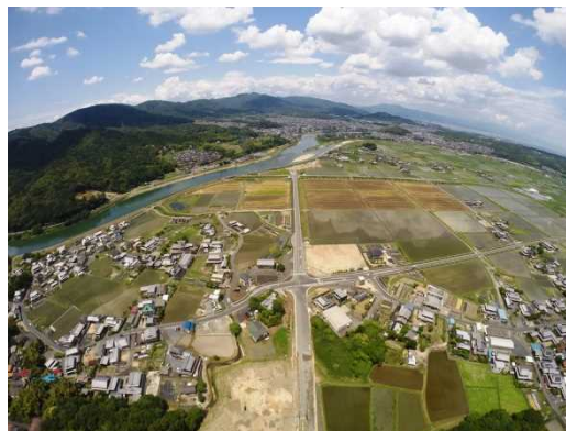
写真-5 瀬田川付近の整備状況(H26.7)
