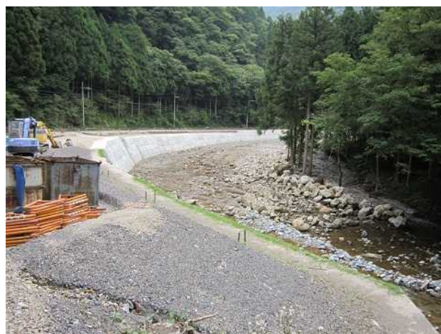
写真-1 本件工事現場状況（10月3日撮影）
