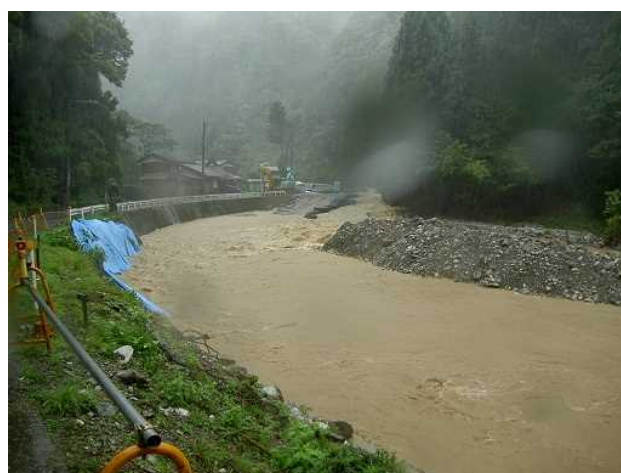
写真3 現場状況（台風中：8月10日撮影）
