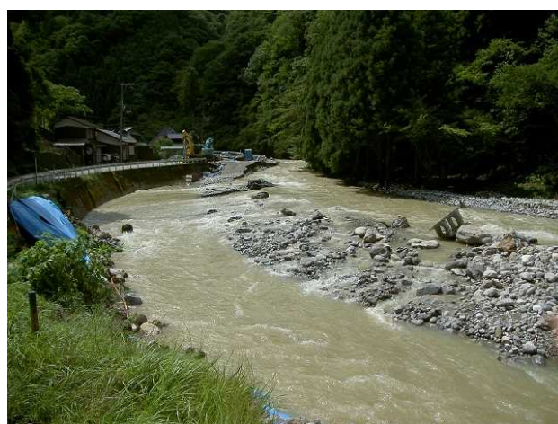
写真4 現場状況（台風後：8月11日撮影）
