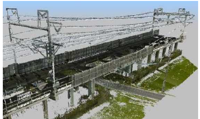
図-17 鉄道高架の点群データ
