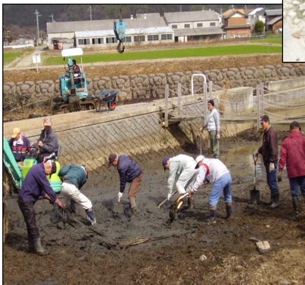
水質浄化池の浚渫
