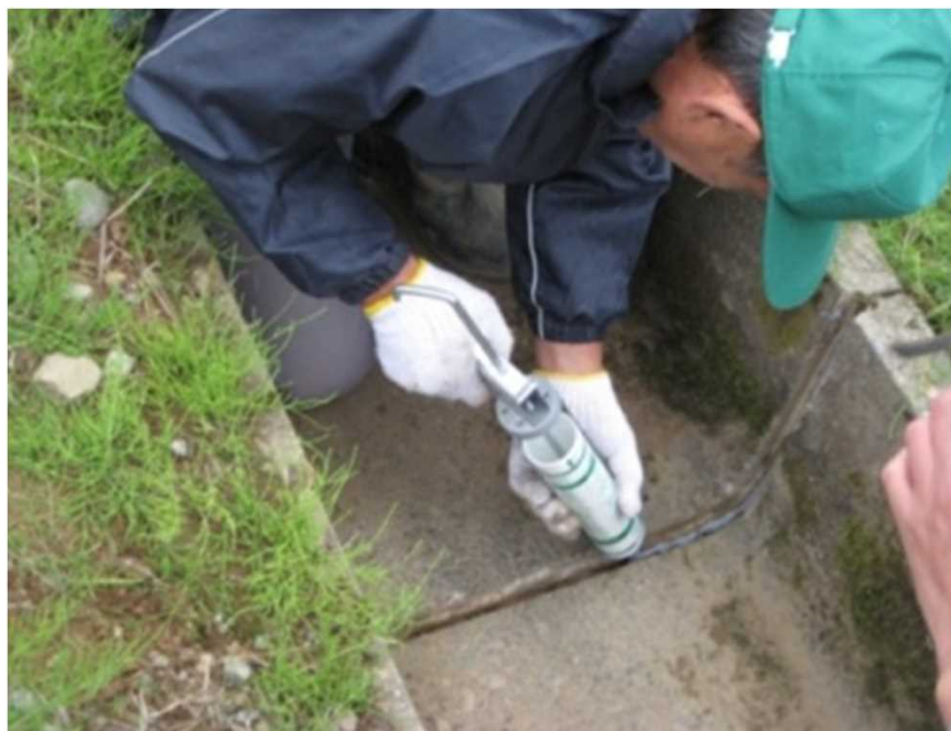
用水路の目地補修
