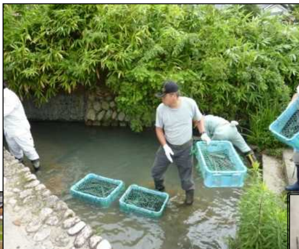
水質浄化のための 竹炭の設置
