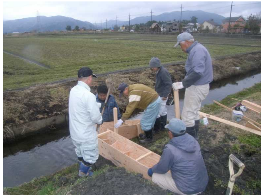
水田魚道製作・設置
