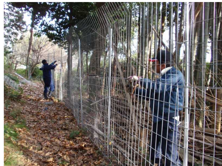
獣害防止柵 設置作業
