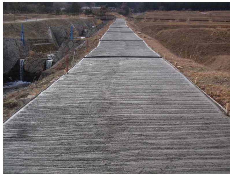
農道舗装 完成
