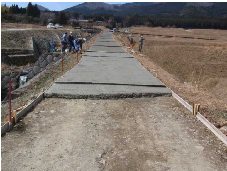
農道舗装 作業中
