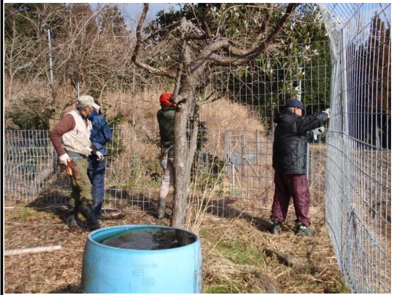
獣害防止柵 設置作業
