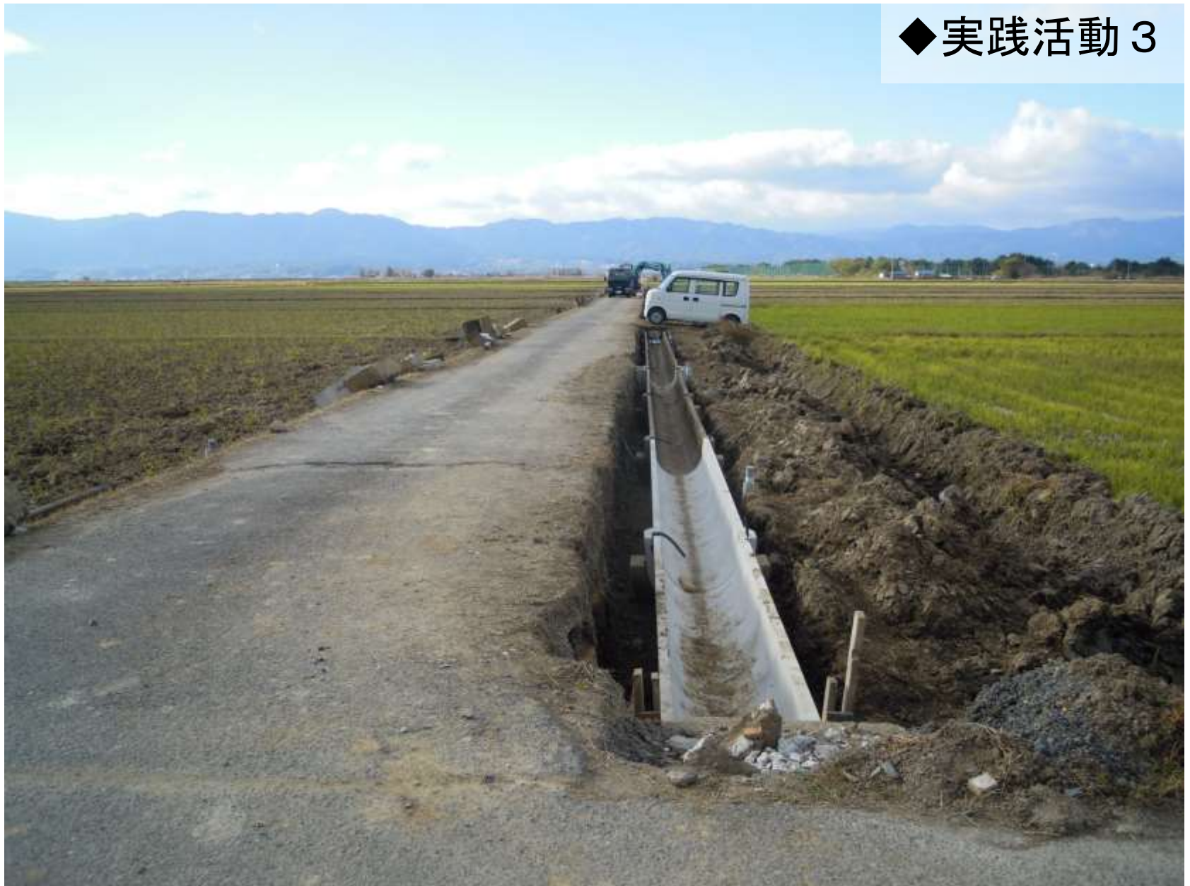
用水路の補修（再布設）（長寿命化）
