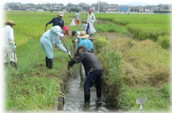
水路の泥上げ
