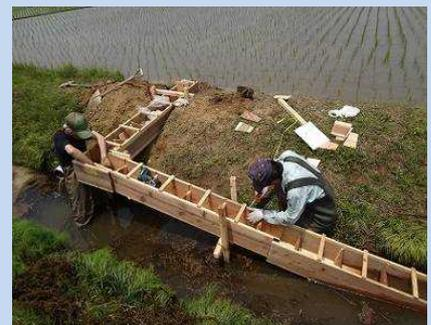
8. 落差部が浮き上がらないよう、落差部の最下段に杭を打ち、番線等で固定する。
