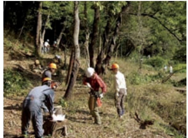
緩衝帯の造成
