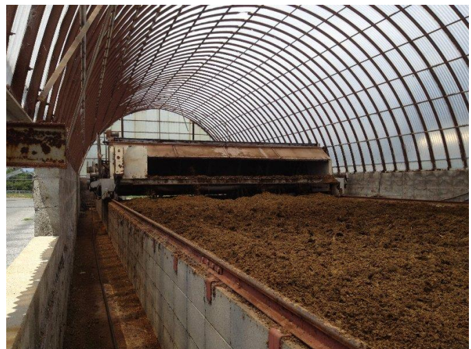
発酵堆肥化施設
