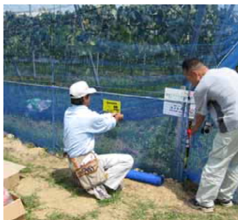
「白落くん」の設置作業（竜王町山之上）
